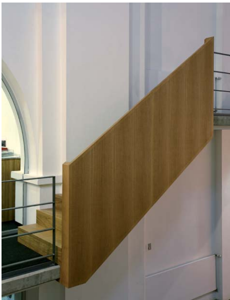
Diskreter Schallschutz. Das Schreinerunternehmen setzte in die Brüstungen Holzabsorber.
