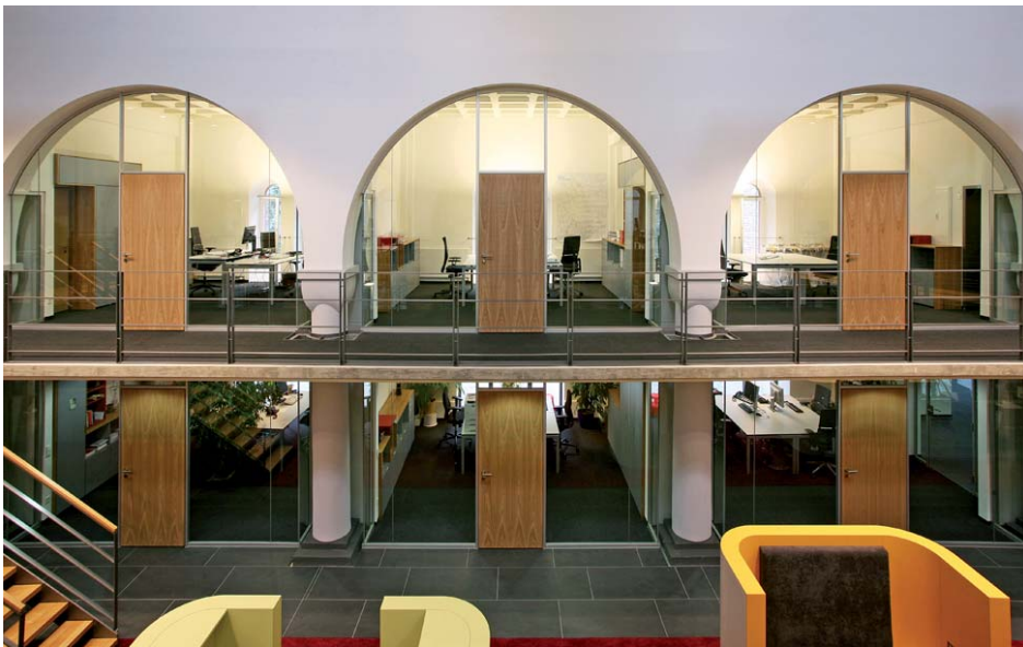
Im Seitenschiff. Die Türen sind zum Hauptschiff hin als Holzabsorber-Paneele ausgebildet. Die Glastrennwände bestehen aus Zwei-Scheiben Schallschutzglas. Die Abschottung ist so effektiv, dass die Feuersirene auf 100 Watt nachgerüstet werden musste.
