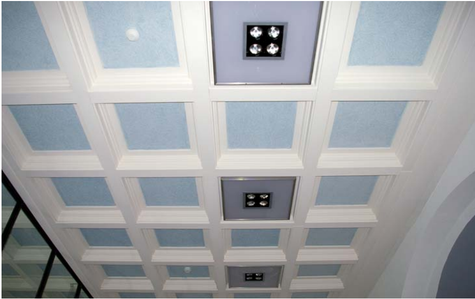
Akustik in alter Kassettendecken. Im Originalzustand bestanden die Kassettfelder aus schichten Sperrholzbrettern. Sie wurden ersetzt durch ein GK-Lochplatte, ein Akustikvlies und einen Akustikputz. Sie ist vom Original nicht zu unterscheiden.
