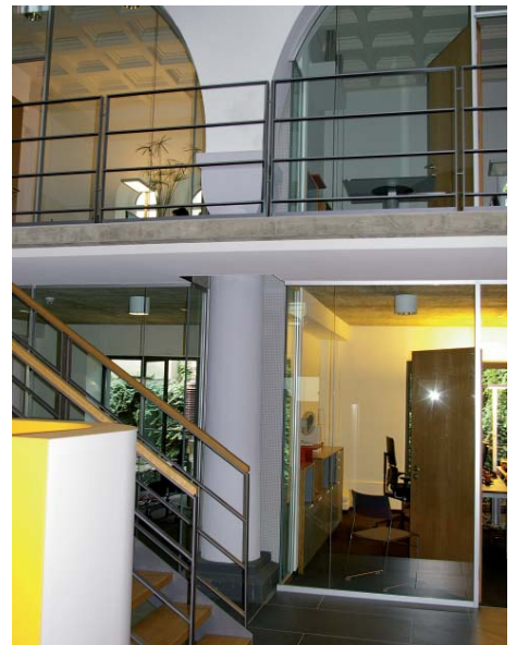
Säulentanz. Da die Säulen frei stehen mussten, wurden dahinter Schallschutzwände aus GK-Lochdecken platziert.
