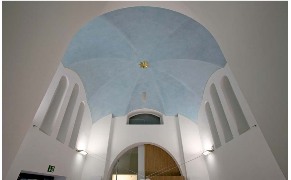
Der ehemalige Chor. Heute sorgt hier eine gefaltete Akustikdecke für die nötige Ruhe. Sie wird auch benötigt, denn der Besprechungsraum wird für weltweite Videokonferenzen eingesetzt.
