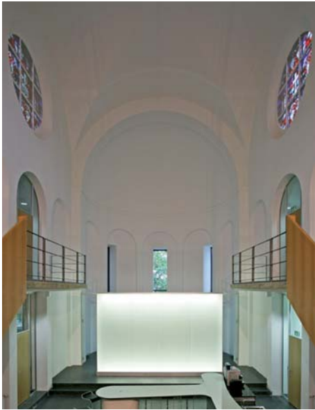
In der Apsis. Diese Nischen wurden von der Fa. Nebis mit Hilfe von Vorwandschalen in riesige Absorber umgewandelt.
