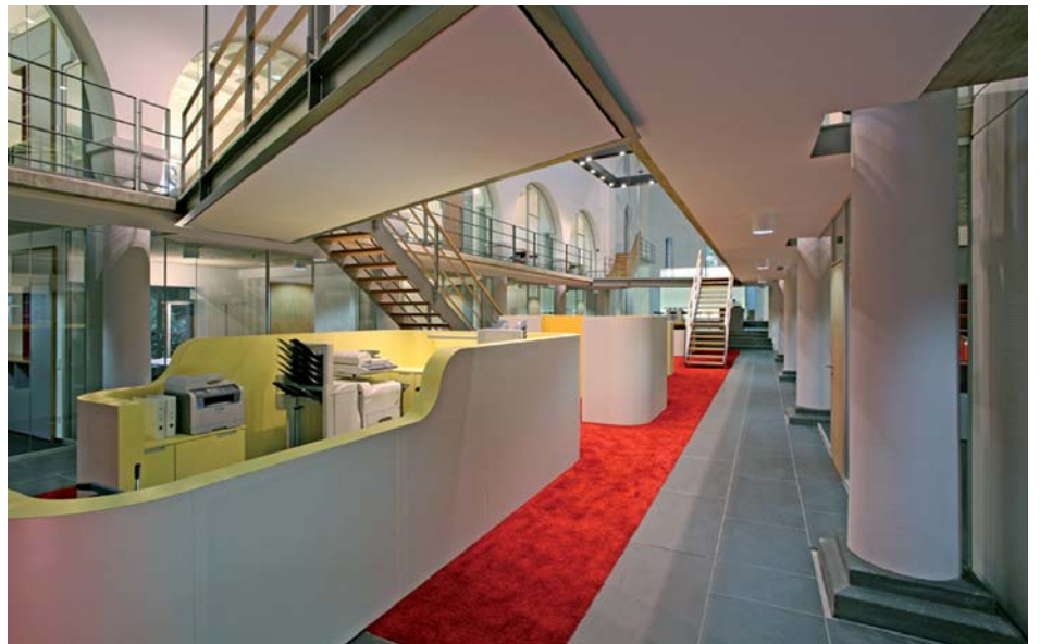
Schall in der Box. Auch die Besprechungsinseln haben Schallabsorber in den Wänden eingebaut. Der rote Poodel-Teppich ist ebenfalls ein Schallschutzobjekt. Die Unterseiten der Galerie wurde mit Akustikputz beschichtet.
