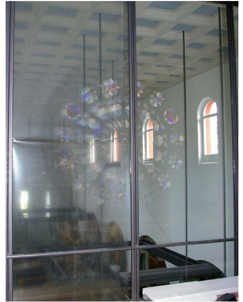
Vor der Glaswand. Ein Drittel der Glasfläche ist zur Dämpfung des Nachhalls mit transparenten Microabsorbieren ausgerüstet.
